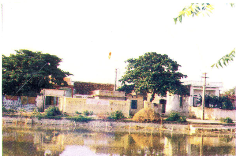
Nhà máy nước Cát Nguyên xây dựng 1996.
