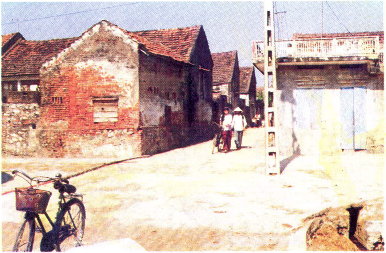
Đường bê tông thôn Phù Lưu hoàn thành 1996.
